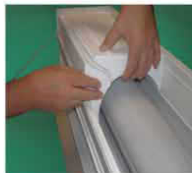
Ugradite izolaciju u kutiju
