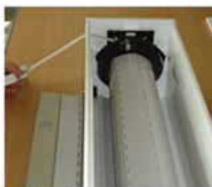
Isječenu lamelu srolati u kutiju i staviti graničnike
