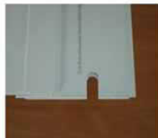
Izgled ufrezanog dijela podnice za uvodnik kaiša
