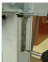
Pričvršćivanje na okvir sa vijcima 4x20 mm ( samorezni )
