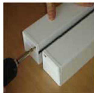
Šarafiti pvc čepove na dno vodilice
