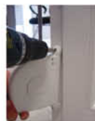
Pričvršćenje automata na prozor
