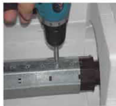
Zašarafite valjak za osovinu
