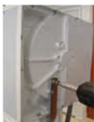
Nosač pričvrstimo sa vijcima 4x12 mm na konzolu. Važno: Vijci ne smiju da budu duži od 12mm !!
