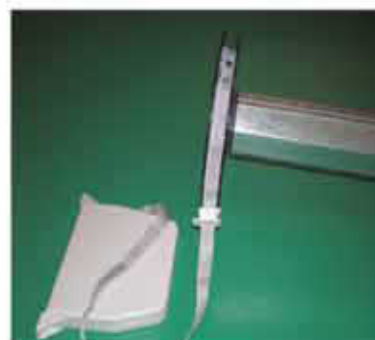
Na pripremljenu osovinu pričvrstite traku za dizanje roletne
