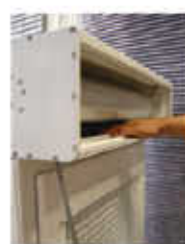
Varijanta B (3.) Kod širih elemenata potrebno je kutiju otvoriti i potisnuti rukom.
