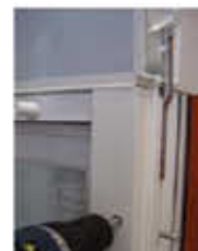
Pričvrstiti vodilicu vijcima 4x40mm
