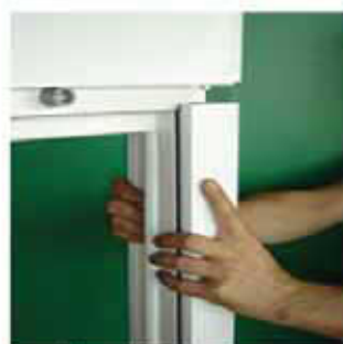
Vodilicu klipsamo na već postavljene šarafe
