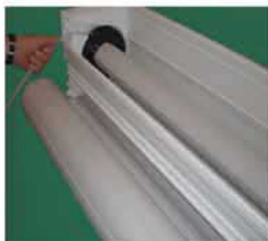
Fiksirajte lamele roletne za osovinu i uvucite roletnu u kutiju
