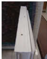
Za pričvršćenje upotrebljavamo samorezne vijke 3,9x19 mm na približno svakih 30cm
